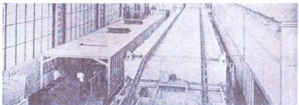
fig.4: Entrée du four de dessiccation
