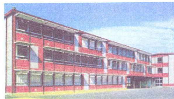
fig. 3: Collège à Hyères (arch. Pierre Le Breton)
