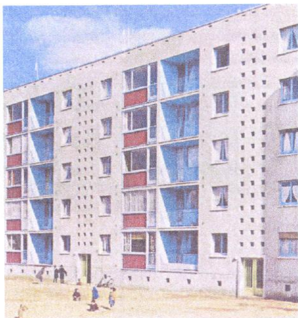
fig.1: HLM des Glonnières au Mans (arch. Pierre Vago)
