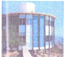
Résidence Prétoria, Afrique du sud (arch. Ivan Sive & Mayvon Langeneau)
