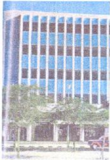
Bâtiment Khalid Al Issa Koweït (arch. Al Handasah Beirut)
